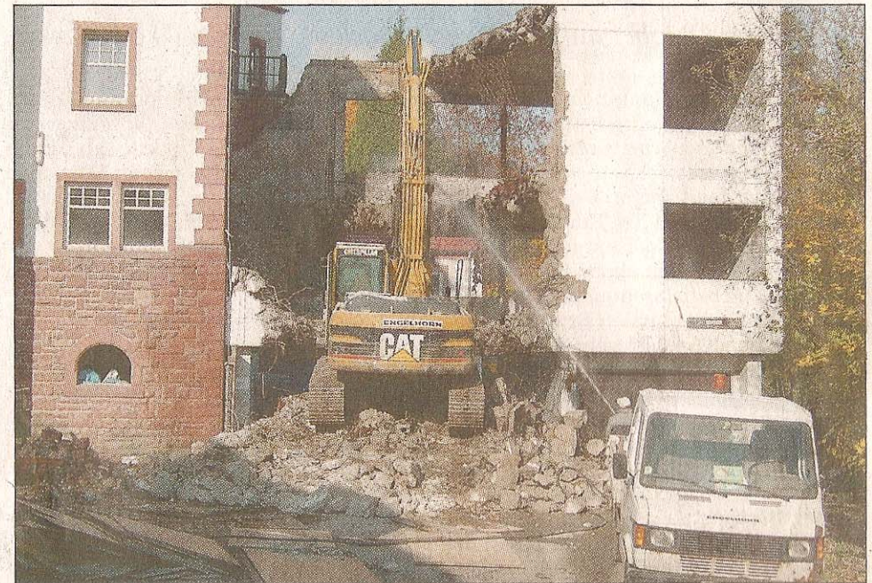
Die Abrissbirne rückte vergangenen Dienstag am ehemaligen Hirschhorner Rathaus an. Statt des Betonbaus sollen dort künftig Balkone das stattliche Gebäude, das aus dem Jahr 1906 stammt, zieren. Foto: Deschner
